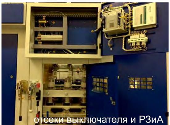
отсеки выключателя и Р3иА
